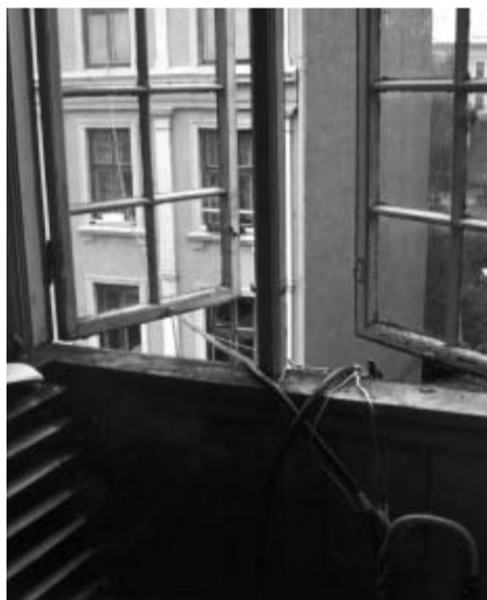
"Navlestrengen" sett fra vannrommet...
