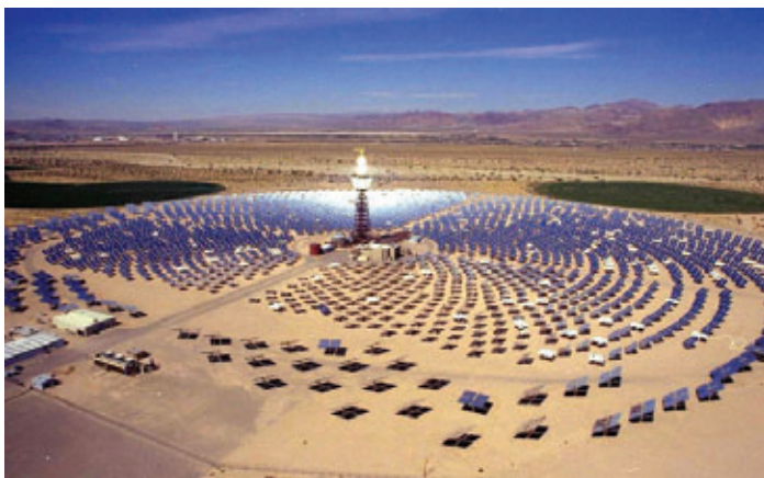
Concentrated Solar Power: mengder av svære speil reflekterer sola mot et tårn, hvor varmen kan drive et vanlig dampturbin-kraftverk. Perfekt i Sahara, nesten gratis energi!
